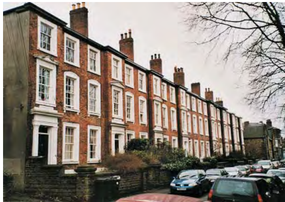
Nos. 6-20 Ashgate Road
