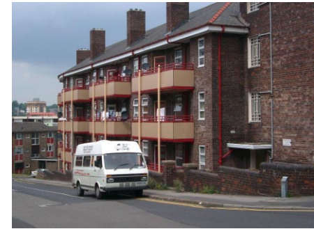
Edward Street Flats
