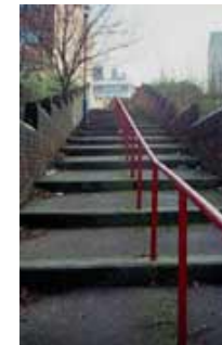
Edward Street flats
